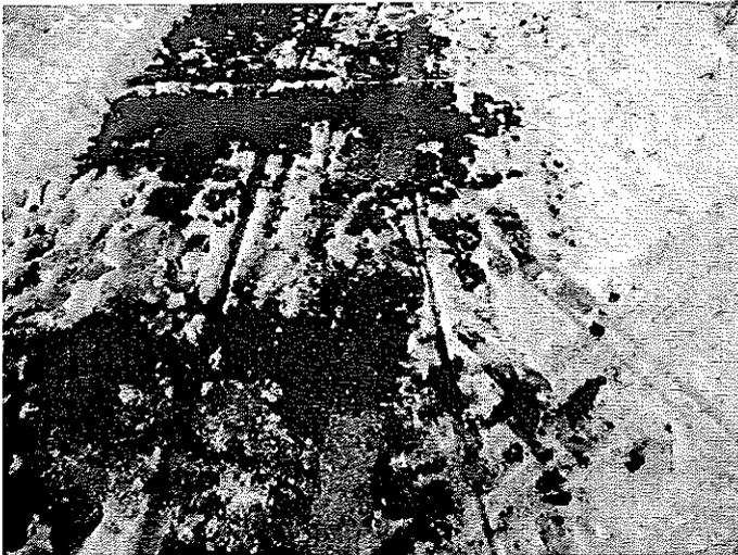
Zur Verbesserung der Erkennbarkeit sollte die Fahrbahnrandmarkierung erneuert werden.
