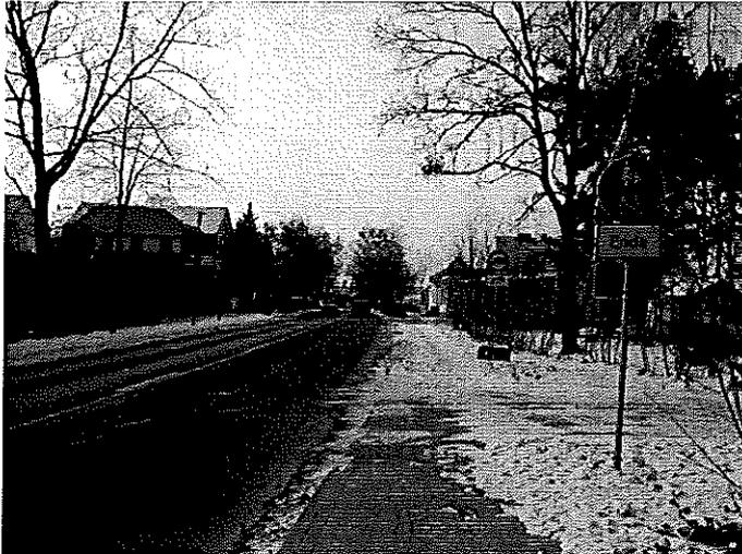
Der Radweg endet an einer Grundstückszufahrt, welche den Übergang zur Fahrbahn unter Berücksichtigung des nachfolgenden Verkehrs gewährleistet.
